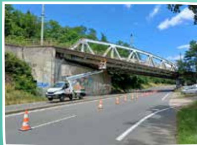
Contrôle d'ouvrage d'art
