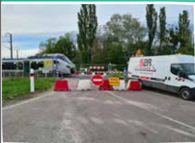
Fermeture de passage à niveau et mise en place de déviation
