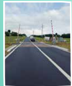
Marquage au sol
